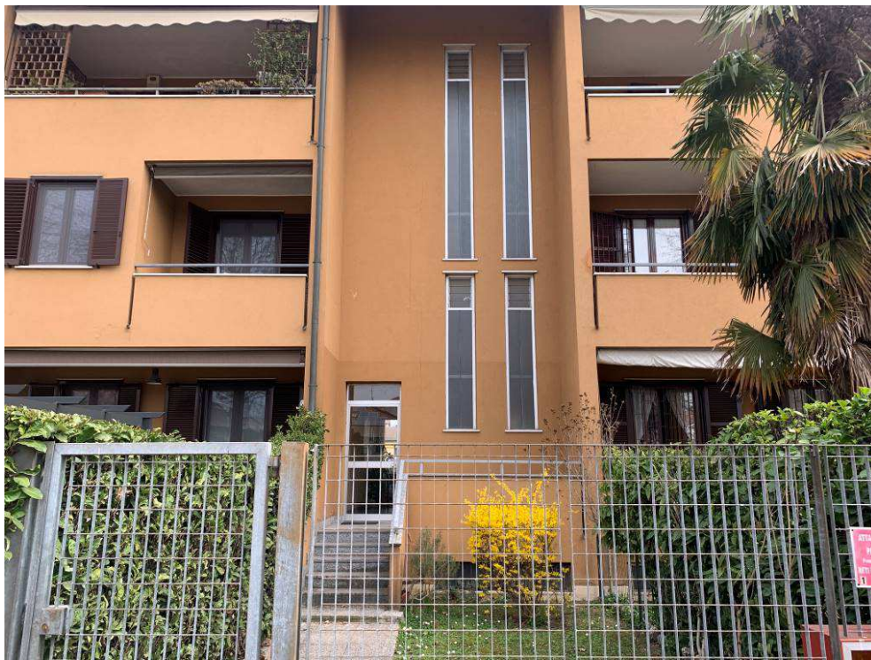
Fotografia n. 42 – Vista del cancelletto pedonale, del cortile comune e del serramento (a destra) del locale cantina
