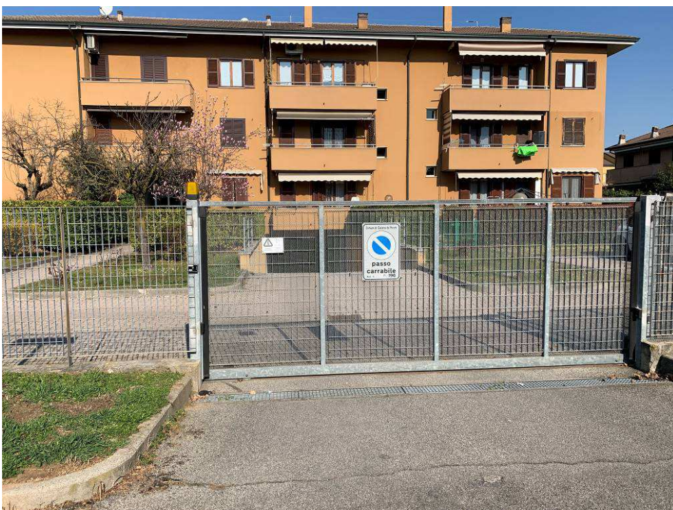
Fotografia n. 3 – Vista del cancello carroia elettrico, attualmente in uso, su Via Bergamo - Cassina de' Pecchi (Mi)
