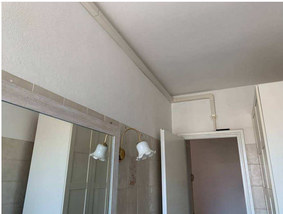
Fotografia n. 32 – Vista del locale bagno, con particolare della canalina esterna dell'impianto di condizionamento
