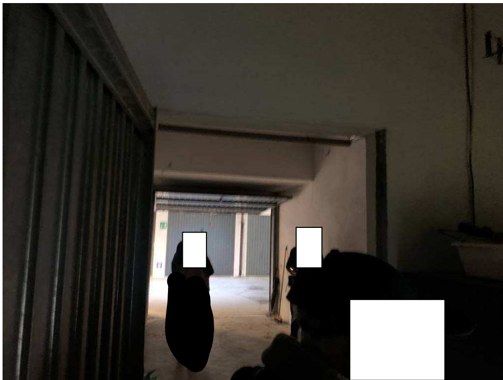
Fotografia n. 36 – Vista dal vano di cantina del box ad uso autorimessa, con il ribassamento in corrispondenza dell'ingresso
